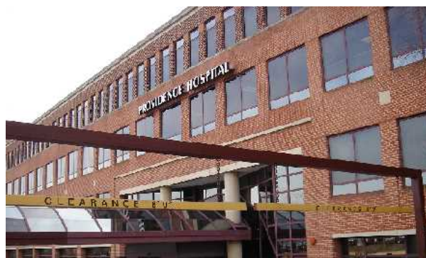
プロビデンス病院の正面玄関より
