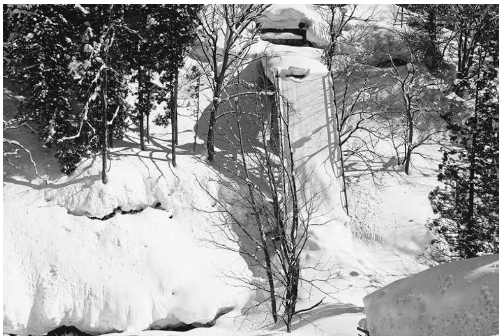
地震と雪の被害で崩落した橋
