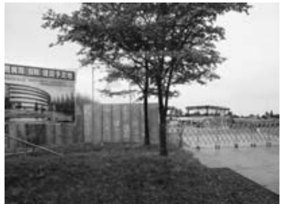
新病院建設現場（とうてい市民が歩いて通院できる場所ではない）
