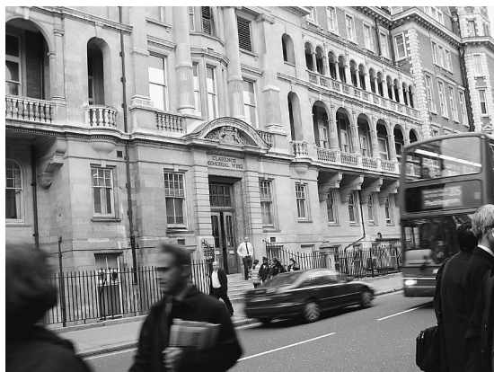
セントマリーズ病院（古い建物）
